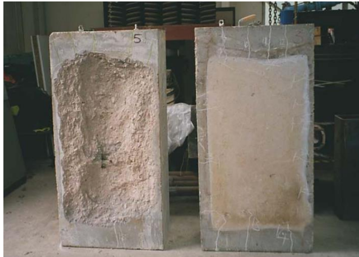
Figura 2. Losas rectangulares luego de la prueba de fuego para el Channel Tunnel Rail Link. Izquierda: sin fibras; derecha: con microfibras de polipropileno [13].
