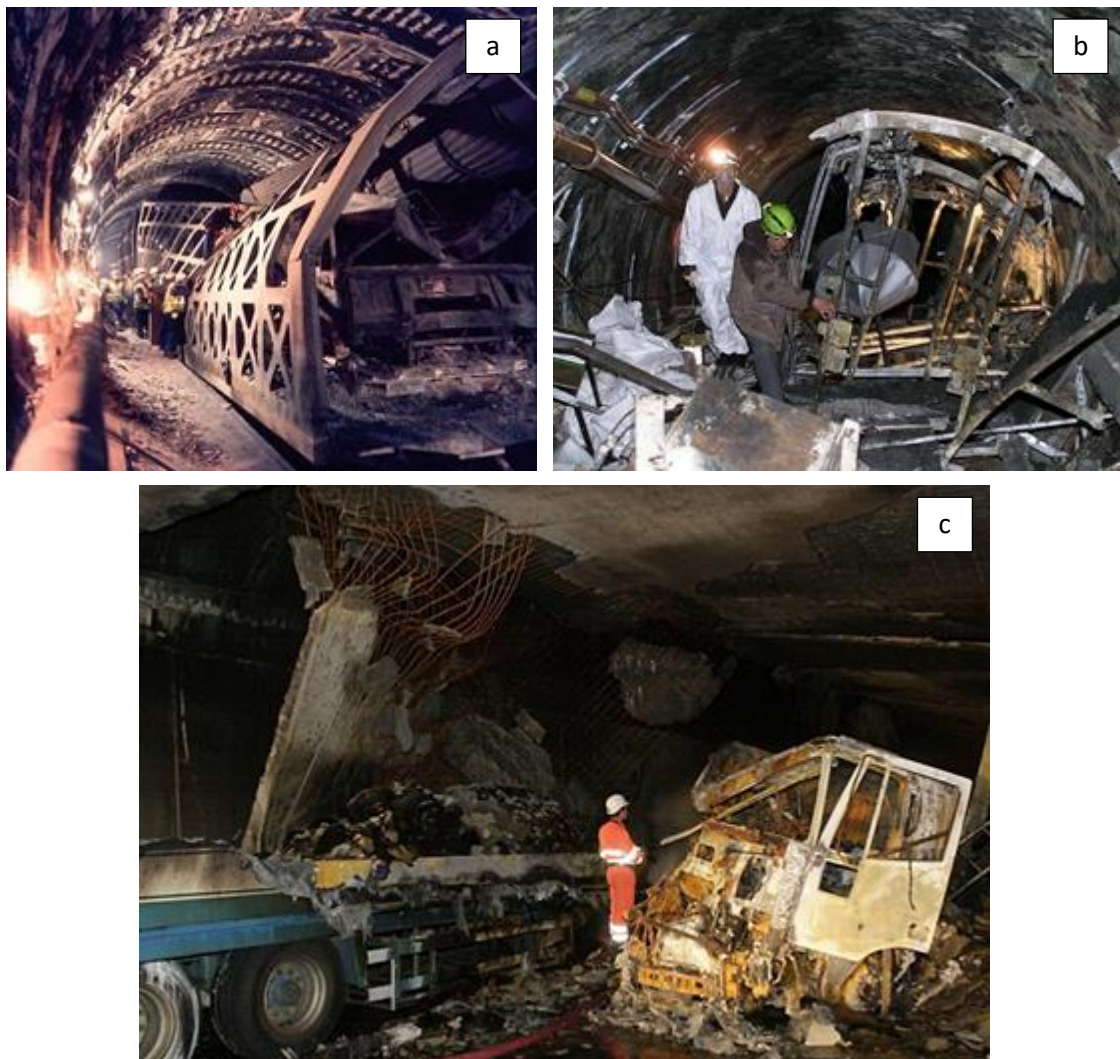
Figura 1. a) Incendio en Channel Tunnel, Reino Unido – Francia, 1996 [8]. b) Incendio en Kaprun Tunnel, Austria, 2000. c) Incendio en Gotthard Tunnel, Suiza, 2001 [8].
