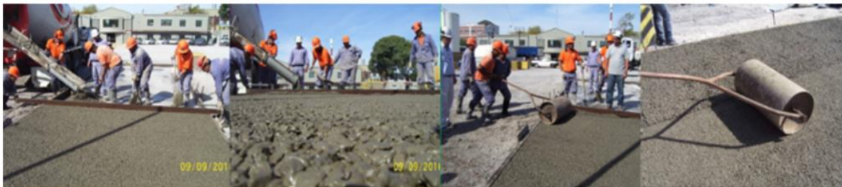
Figura 8. Aplicaciones de hormigones drenantes [27].
